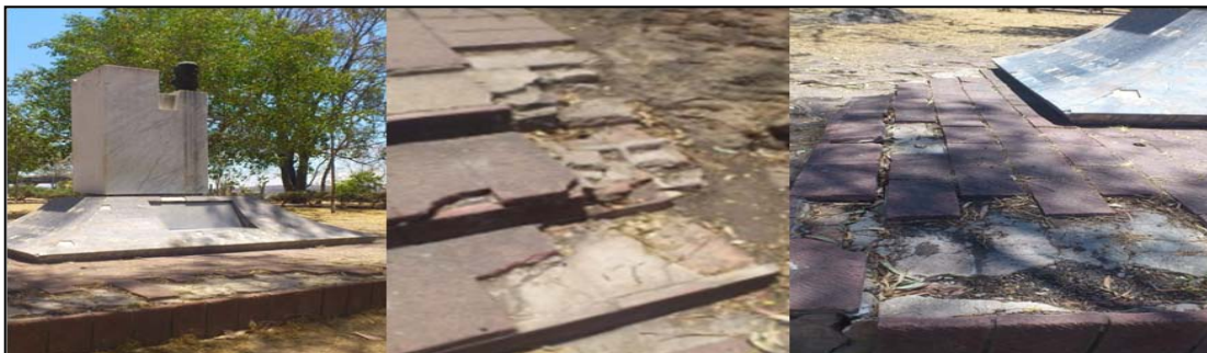
Gráfica 3. Condiciones actuales de las instalaciones del parque. Foto: Agustín Rivera.
