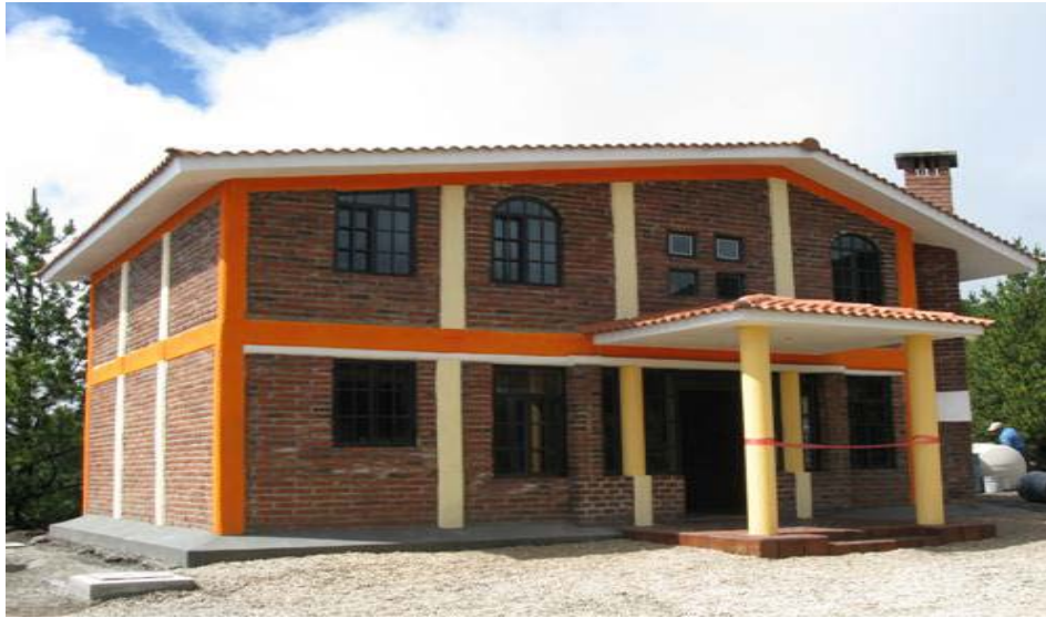
Figura 1. Centro operativo “Pico del águila” que proporciona condiciones seguras, dignas y confortables para el personal operativo del parque.
